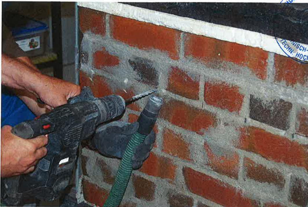
Bild B1: Einbringen der Bohrlöcher senkrecht in die vertikal verspannten Prüfkörper
