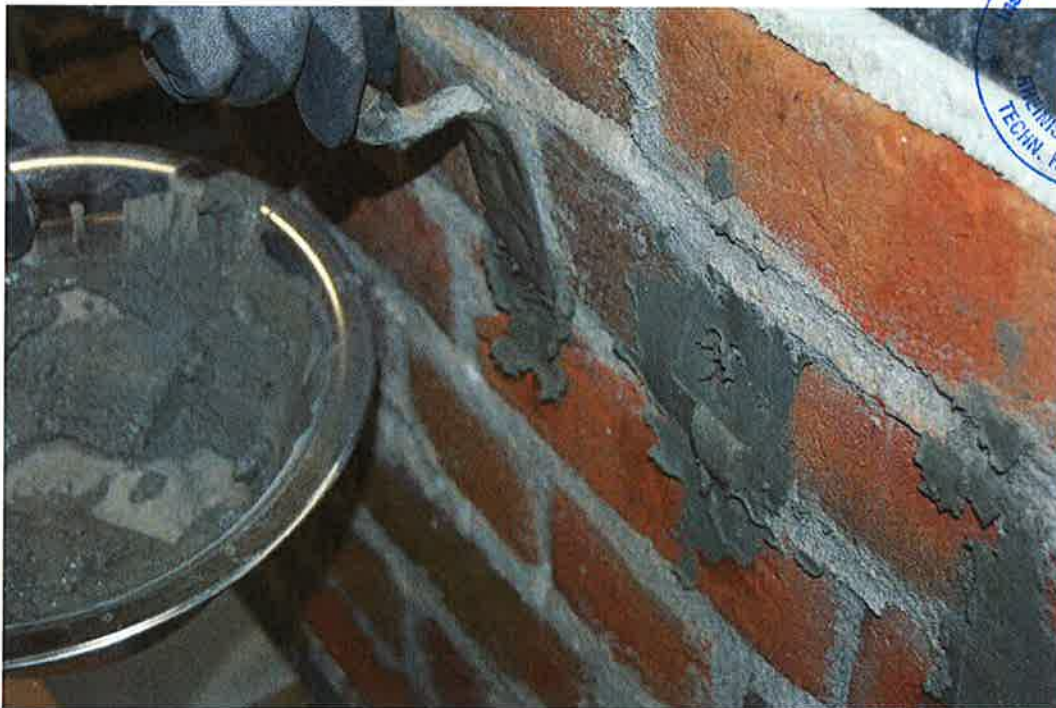
Bild B4: Verschließen der Injektionslöcher mit Schnellzement
