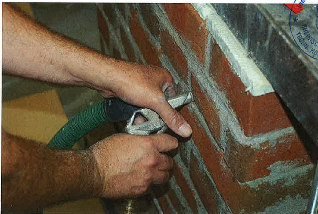
Bild B2: Ausblasen von Bohrmehlrückständen mit ölfreier Druckluft
