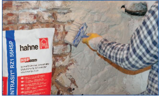
Flächenabdichtung mit **INTRASIT® RZ1 55HSP** als Schlämmauftrag oder als Dichtungsmörtel mit anschließendem Haftspritzbewurf
